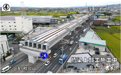
横田町交差点から北を望む
