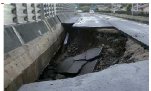
写真④R1.10台風19号による国道42号の陥没（串本町姫）
