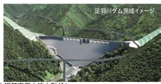
平常時は、水を貯めない洪水調節専用の流水型ダム。 高さ約96mの重力式コンクリートダムで、足羽川の支川の部子川に建設。
