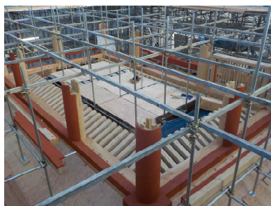
南門の復元整備の状況
