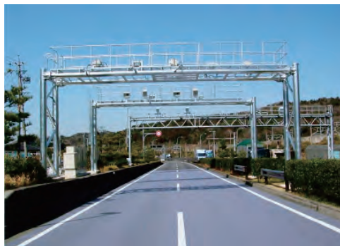
車両重量自動計測装置による計測
