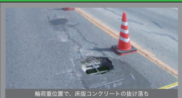
輪荷重位置で床版コンクリートが（鉄筋を残して）落下した状況
