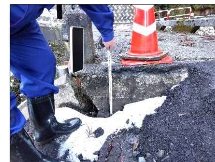
—応急復旧状況（橋梁部の段差）—
