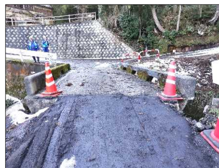
—応急復旧状況（橋梁部の段差）—
