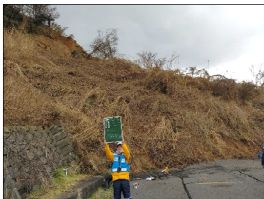
—被災状況（土砂崩落）—
