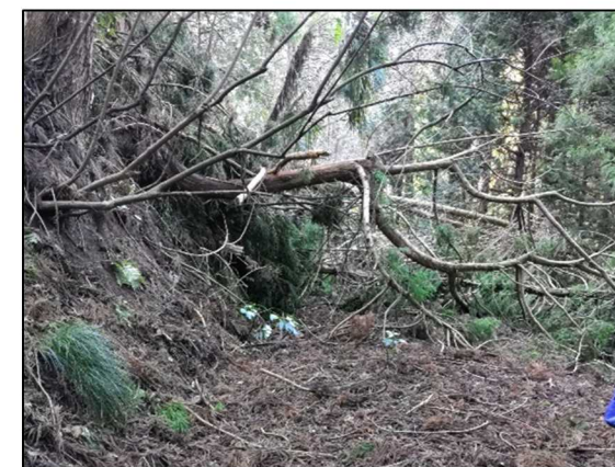
—被災状況（倒木）—
