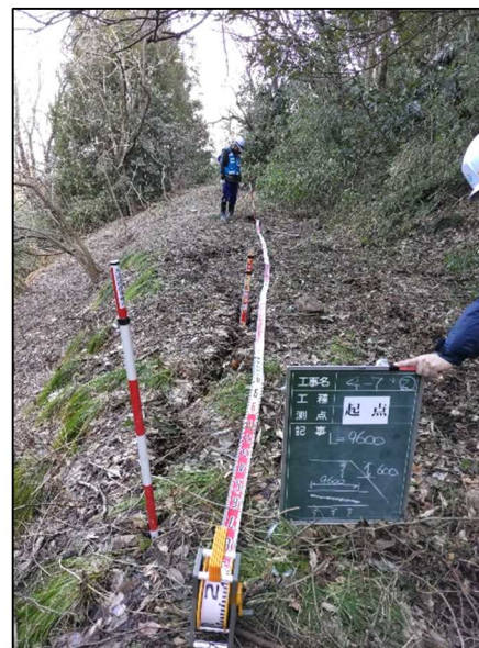
—被災状況（亀裂）—
