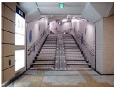
斜路付階段(3号、4号出口)
