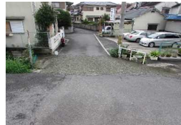
藤井寺市 大井35号線1号橋
