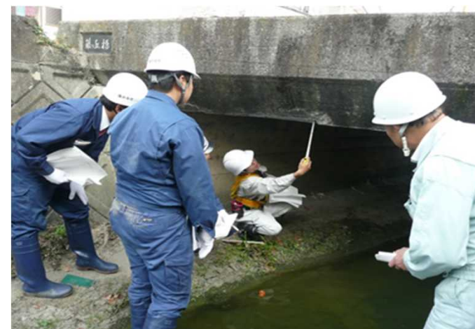
H27.11.6 藤井寺市 藤が丘2線 藤が丘橋
