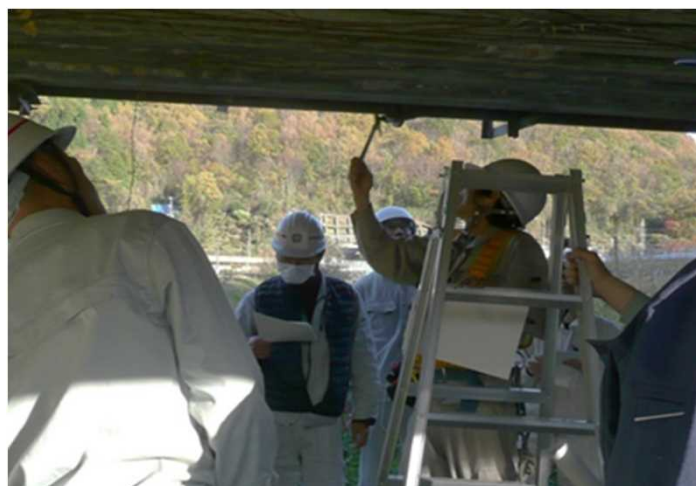
H27.11.20 豊能町 町道宮ノ下線 城山橋
