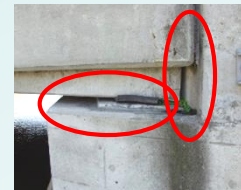
支承交換や桁端点検の空間なし
