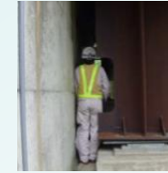
支承交換や桁端点検の空間なし
