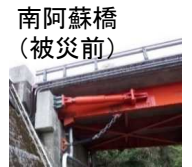
南阿蘇橋（被災前） 制震ダンパー取り付け部の損傷
