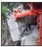
南阿蘇橋（被災前） 制震ダンパー取り付け部の損傷
