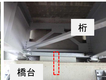
写真-5 アンカーバーのイメージ
