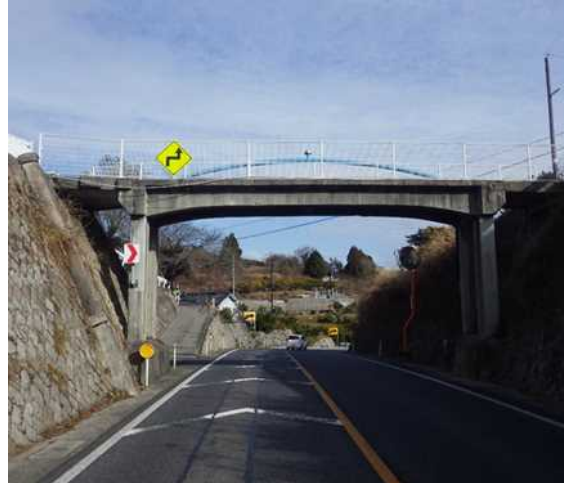
地方管理の跨道橋(未対策)
