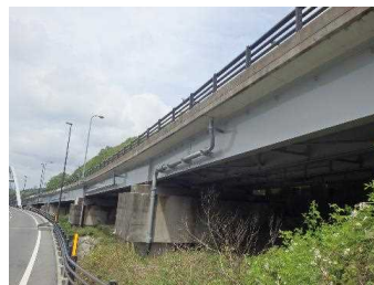
写真-4 阿蘇口大橋 (国道57号)
