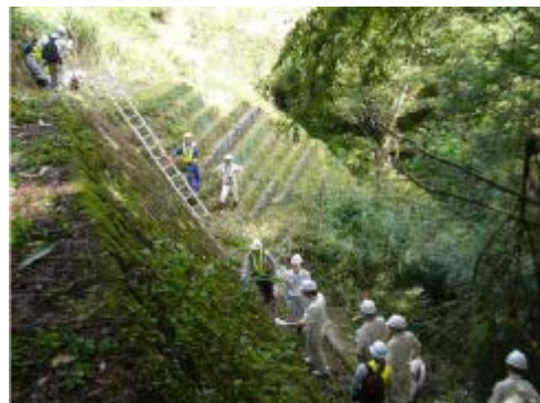
道路防災ドクターによる現地診断
