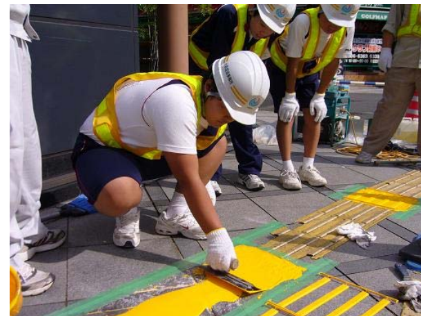
点字ブロックの張り替え体験
