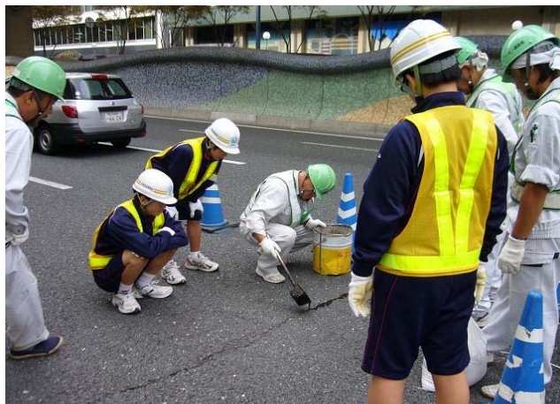
ひび割れ補修現場の見学
