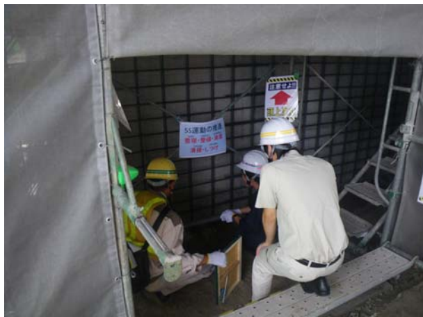
橋梁補修の現場見学
