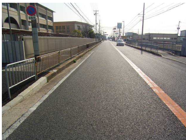
工事前の状況
