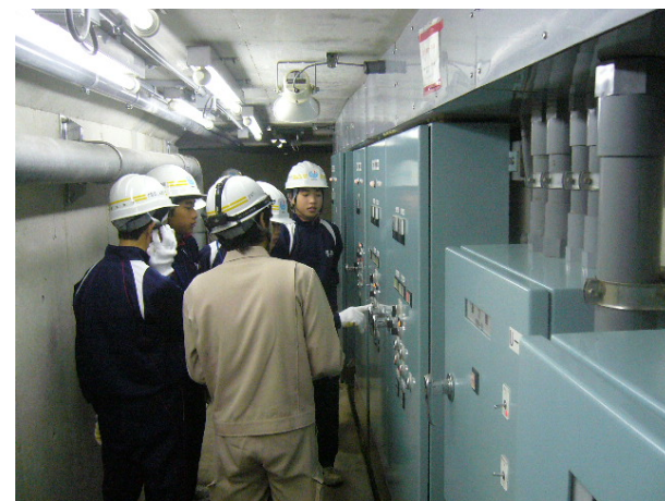
梅田共同溝内の点検
