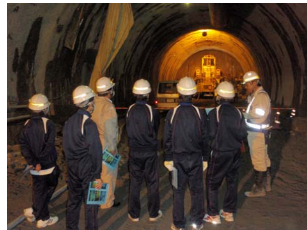
清滝トンネル工事現場の見学
