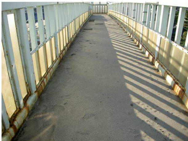
工事前の状況
