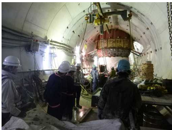
御堂筋共同溝立坑工事の現場見学
