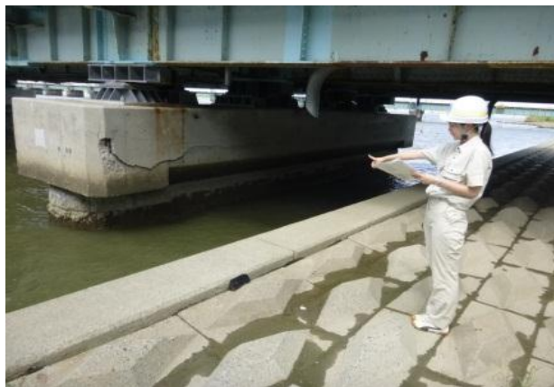
橋梁補修予定箇所の見学
