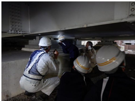
桜宮橋での橋梁点検体験
