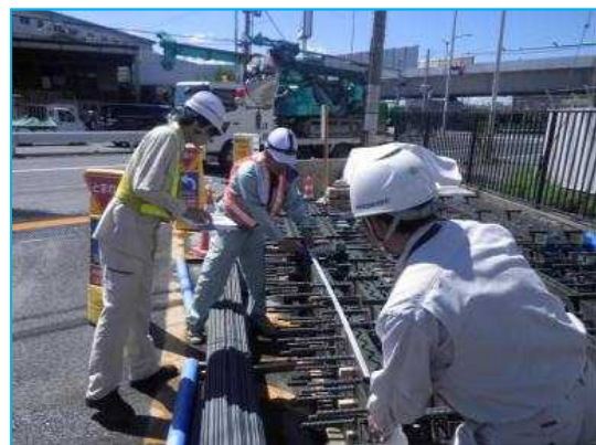
[国道1号守口高架橋]
