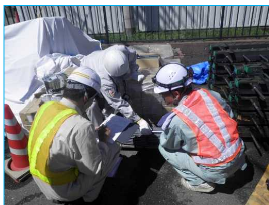
[国道1号守口高架橋]
