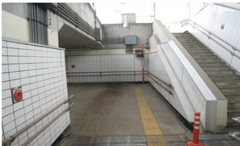
国道26号 幡代第二地下道
