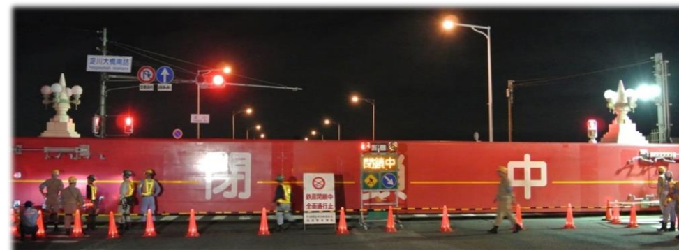
—防潮鉄扉閉鎖完了—
