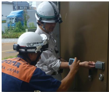
—設備確認状況—
