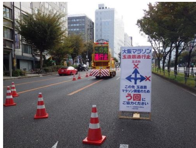
「玉造筋通行止め」の規制看板設置
