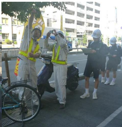
街路樹の高さを調査中
