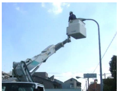
高所作業車のリフトに乗車「高い～！」
