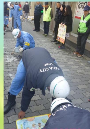
路面シート貼付状況
