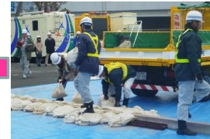
疑似段差設置
