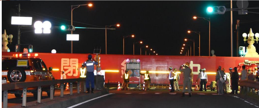
— 防潮扉開閉及び閉鎖状況—
