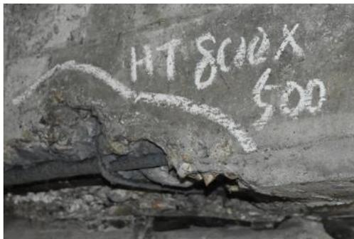
↑ 剥離鉄筋露出
