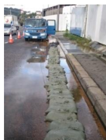
= 25号土のうによる冠水抑制 =
