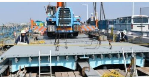
新しい床版の設置作業
