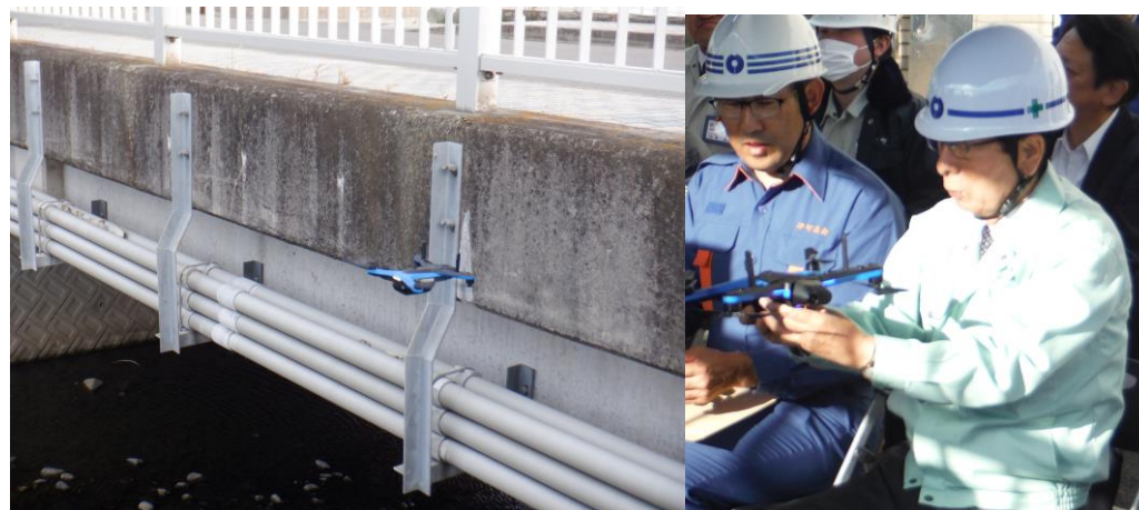
360度周囲を認識するドローンを用いた橋梁点検支援技術
