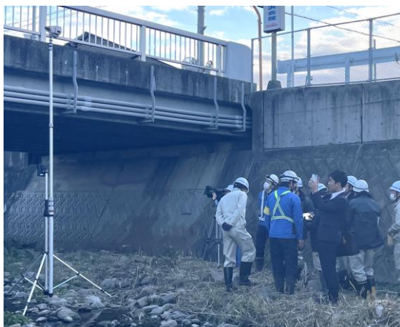
橋梁等構造物の点検ロボットカメラ
