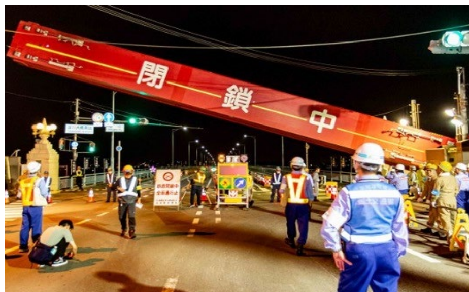
よどがわりっこう 淀川陸閘 閉鎖中 1時22分 (国道2号 淀川大橋左岸)
