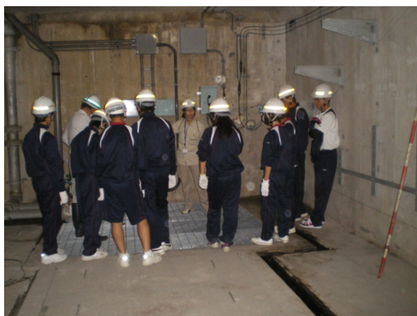
共同溝内の点検作業
