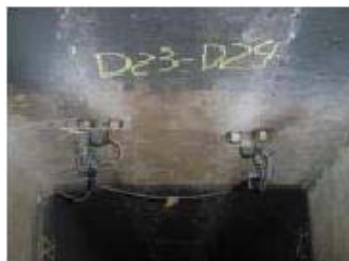
図-10 変位計設置状況
