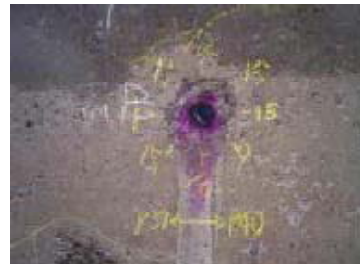
図-13 コア採取箇所中性化試験
