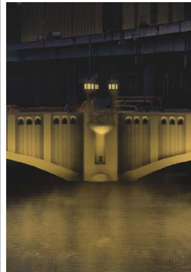
側面全体への光に加え、欄干やバルコニー部分への光を加えることによって橋の凹凸が強調され、落ち着き・風格とともに優美な印象を与えます。
