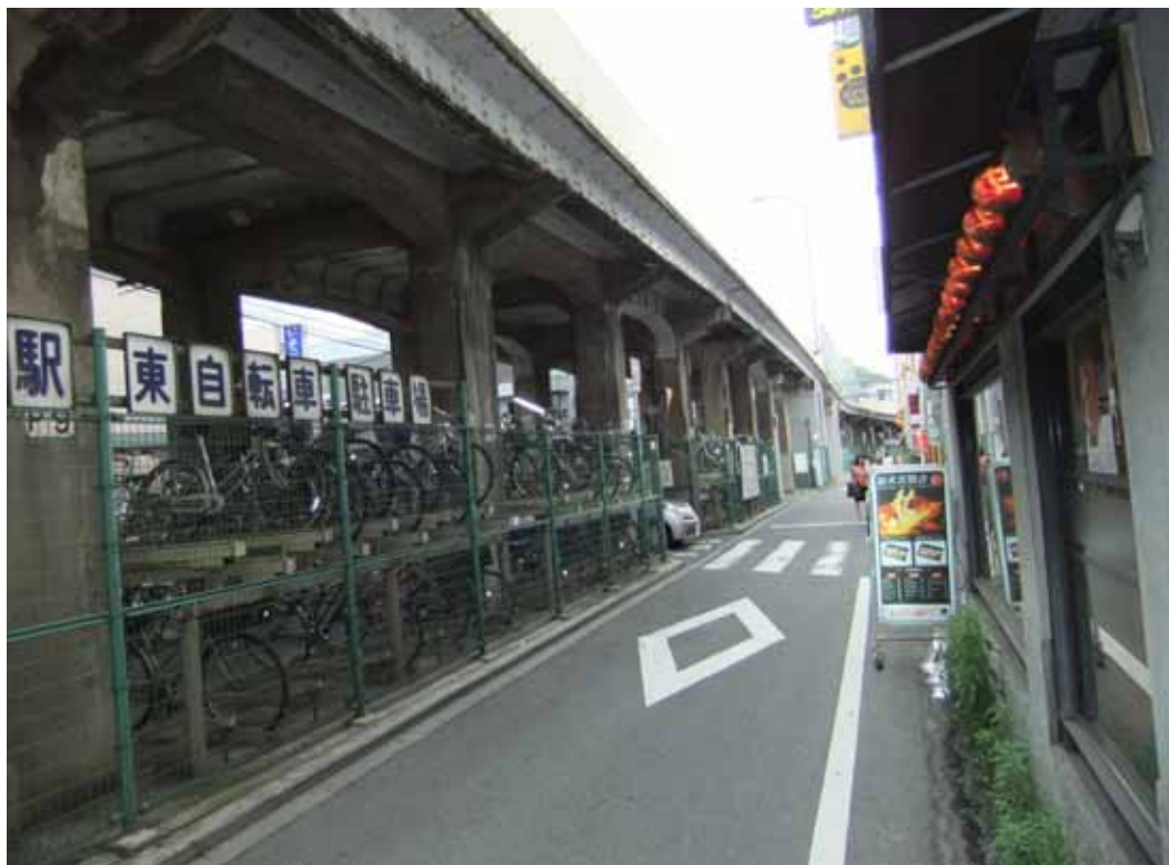
石橋跨線橋（現況）
