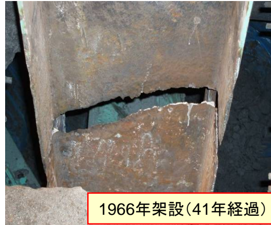
本荘大橋 2007年8月 (トラス橋の斜材の破断)
