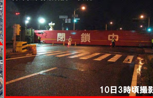
右岸陸閘閉鎖後の状況
