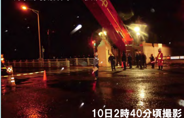
左岸陸閘閉鎖中の状況
