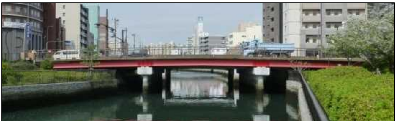
▲住吉橋 側面全景(上流側より)
