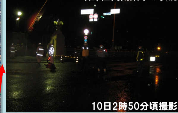
右岸陸閘閉鎖中の状況
