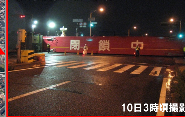
右岸陸閘閉鎖後の状況
