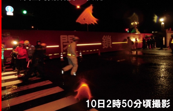
左岸陸閘閉鎖後の状況
