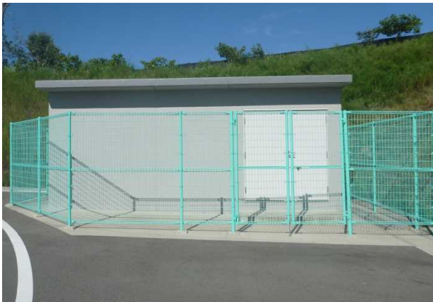
備蓄倉庫(外観)
