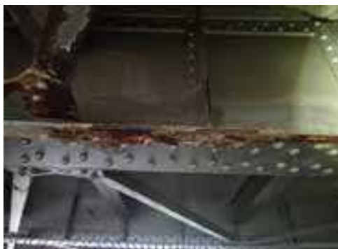
鋼材の腐食
