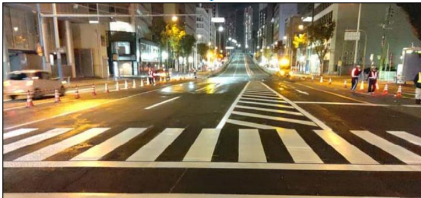
舗装及び区画線の復旧（施工後）
