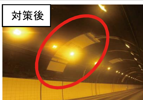
断面修復・剥落防止
