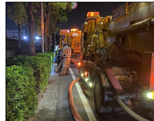
管渠（かんきょ）清掃
