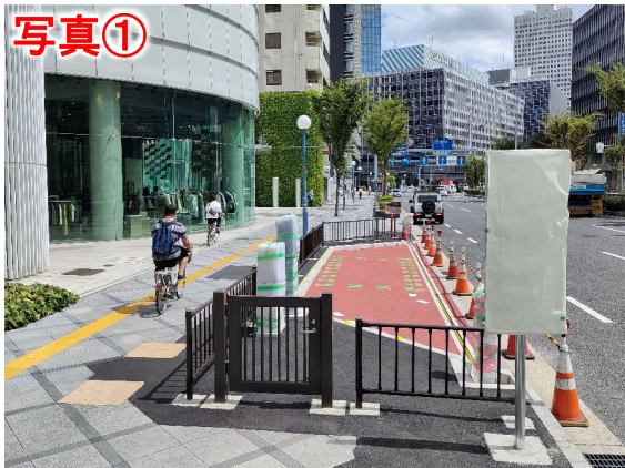
状況写真 R6. 8. 30撮影
