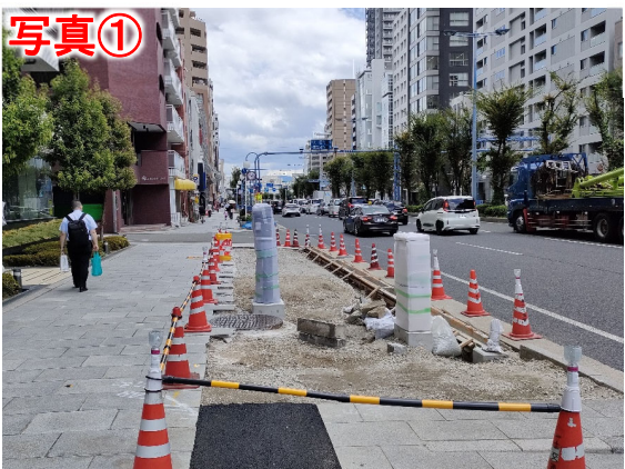
状況写真 R6. 8. 30撮影
