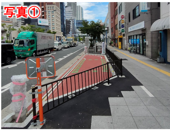
状況写真 R6. 8. 30撮影
