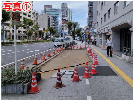
状況写真 R6. 8. 30撮影
