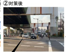
左直混用車線の拡幅により左折待ち車両による直進車両の通行阻害が解消！
