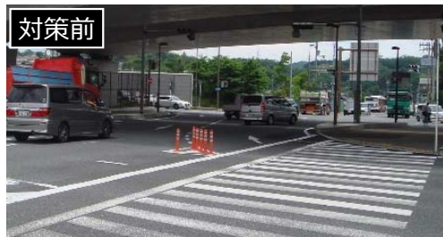
【写真】津田北町3交差点の対策状況
